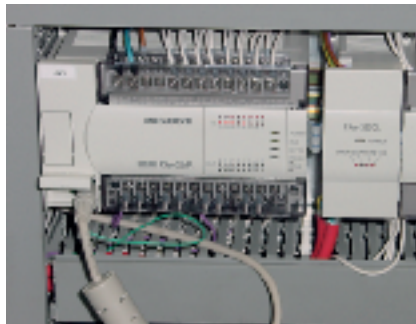
Aufschaltung der E/A-Peripherie an CC-Link-Module (links) und CC-Link-Kommunikationsmodul der Kompaktsteuerung Melsec FX (rechts, Mitte).
