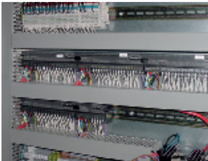
Aufschaltung der E/A-Peripherie an CC-Link-Module (links) und CC-Link-Kommunikationsmodul der Kompaktsteuerung Melsec FX (rechts, Mitte).
